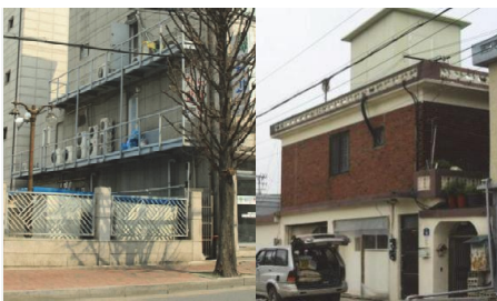
건축물 외부로 노출된 설비시설
