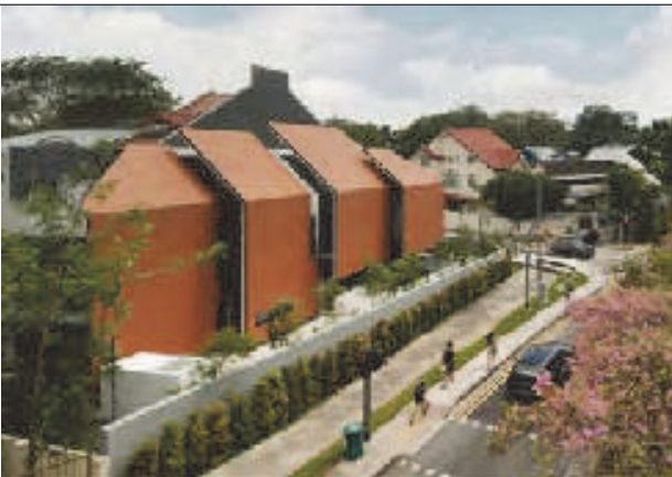
공사 가림막 및 산업시설(공장) 식재 및 디자인 적용하여 차폐감 상쇄
