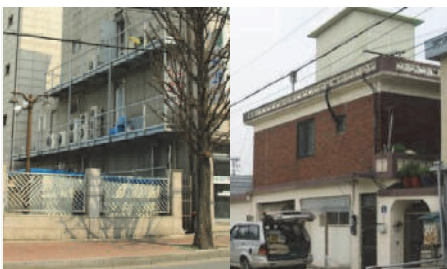
건축물 외부로 노출된 설비시설
